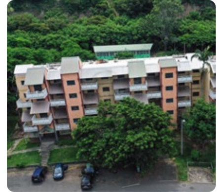
163 logements à démolir à Tindu et Pierre Lenquette
