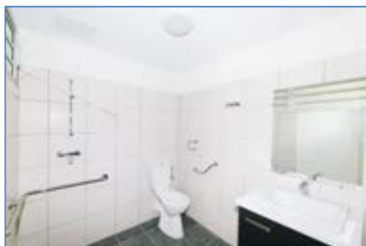
Salle de bains aménagée pour personne à mobilité réduite
