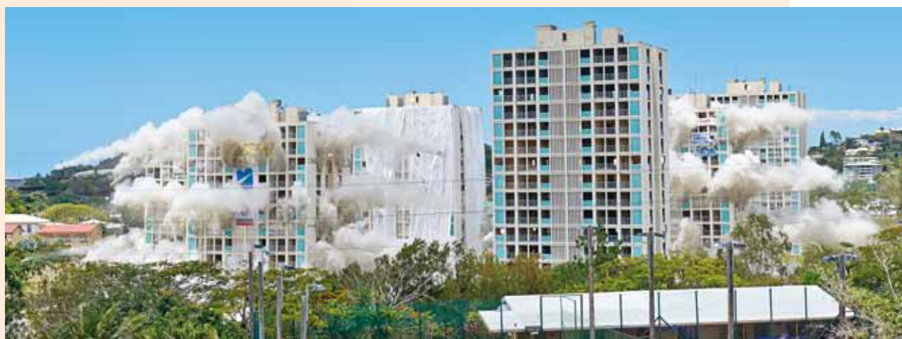
Démolition de quatre tours à Saint-Quentin le 8 novembre 2015.
